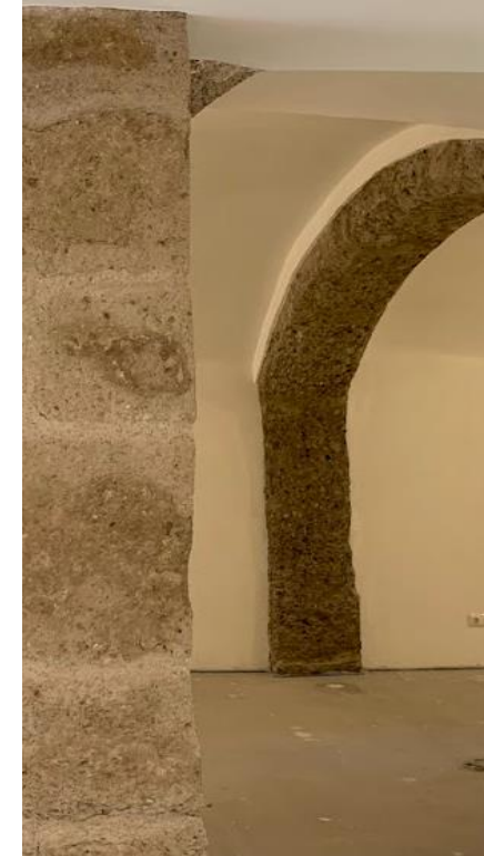
Gurtbogen, Tonnengewölbe, Konglomeratwand
