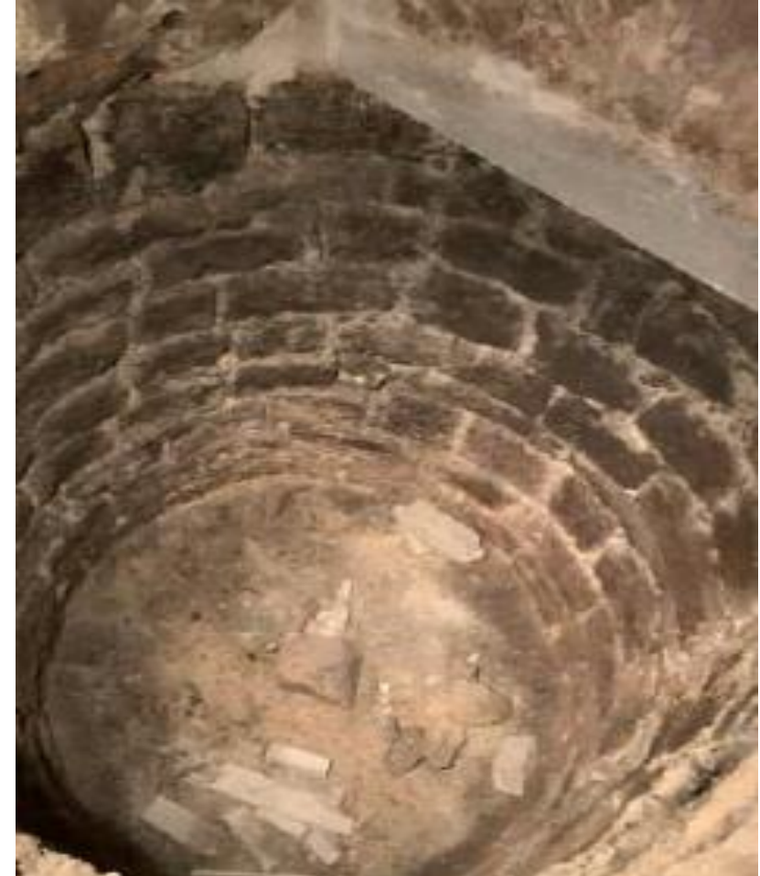
Lederergasse 3: Senkgrube aus Konglomeratquaderblöcken
