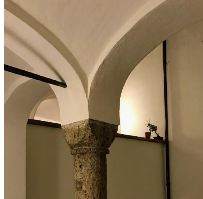
Lederergasse 3: Konglomeratsäule im Innenhof, dünnchaliges Gewölbe mit Eisenzugbänder
